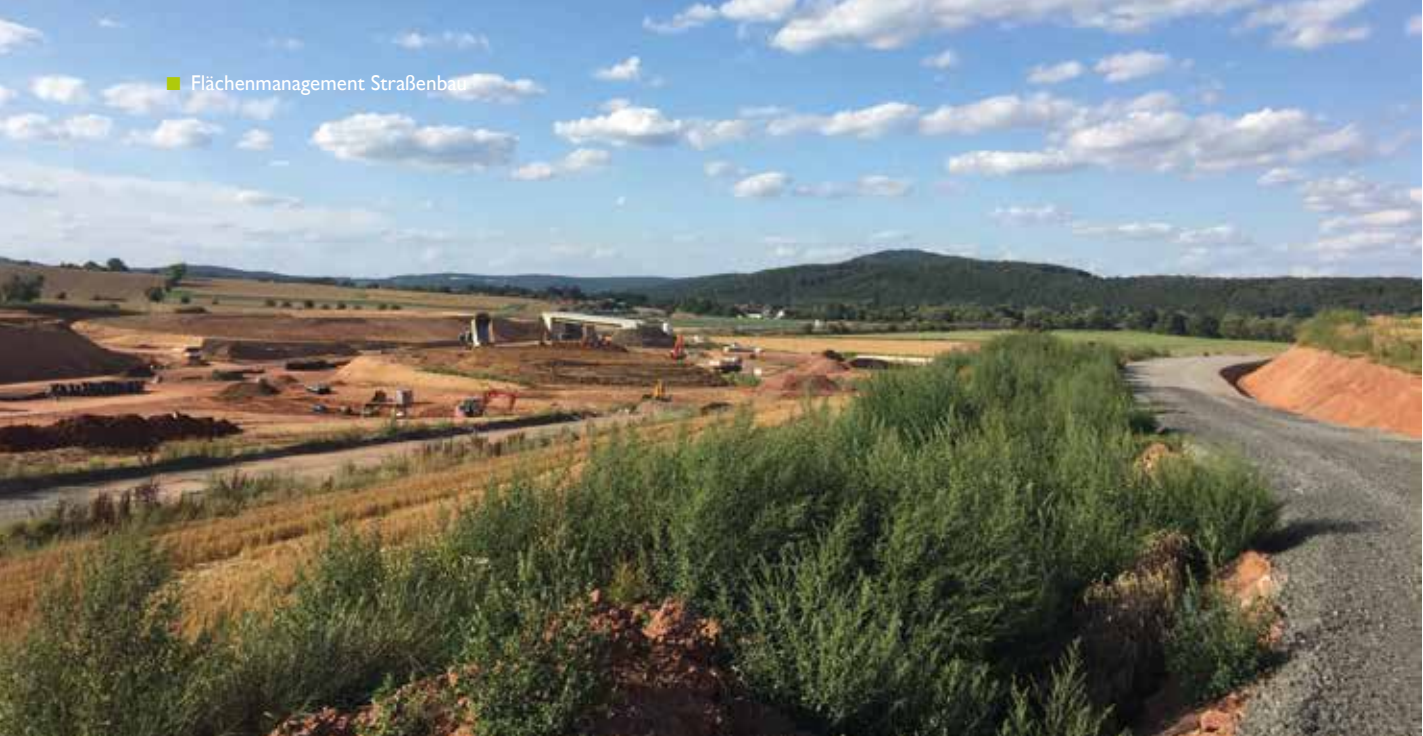
Abb. Seite 56 und 58: Neubau der BAB 49 bei Neuental-Bischhausen, Schwalm-Eder-Kreis
