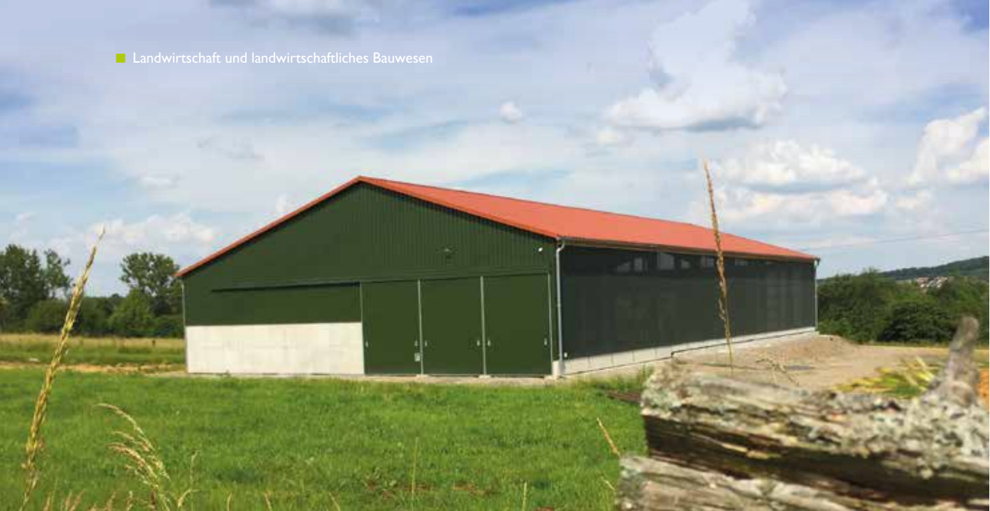
Neubau eines Mutterkühstalles mit Mistlager in Wettengel, Landkreis Gießen
