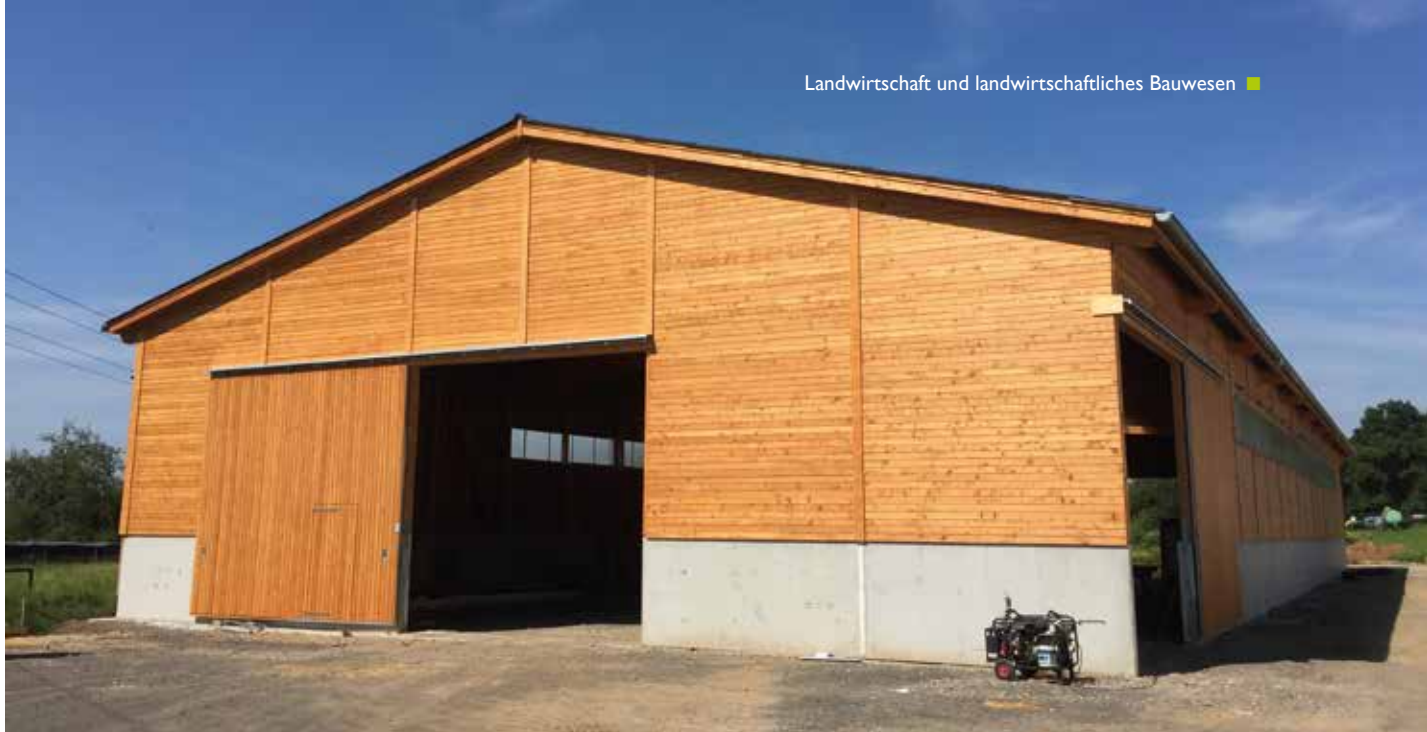
Neubau eines Schafstalles in Hungen, Landkreis Gießen
