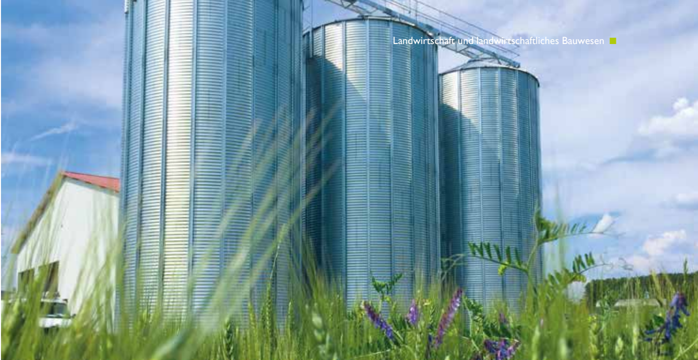
Beide Abb.: Neubau einer Siloanlage in Wettenberg, Landkreis Gießen
