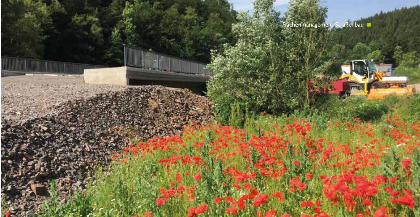
Beide Abb.: Neubau der Ortsumgehung B 252 Dorfitter, Landkreis Waldeck-Frankenberg
