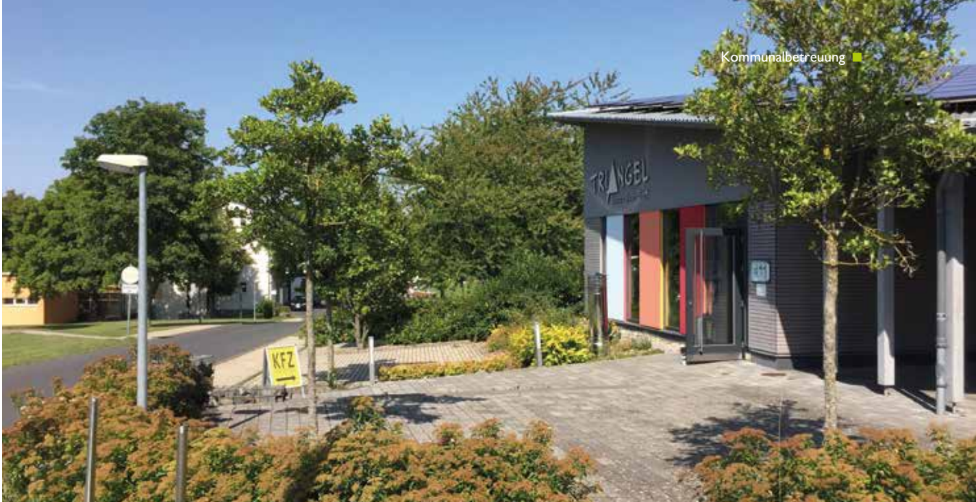
Umnutzung der ehemaligen Kasernenanlagen in Homberg (Efze) im Schwalm-Eder-Kreis u. a. zu einem Behördenzentrum
