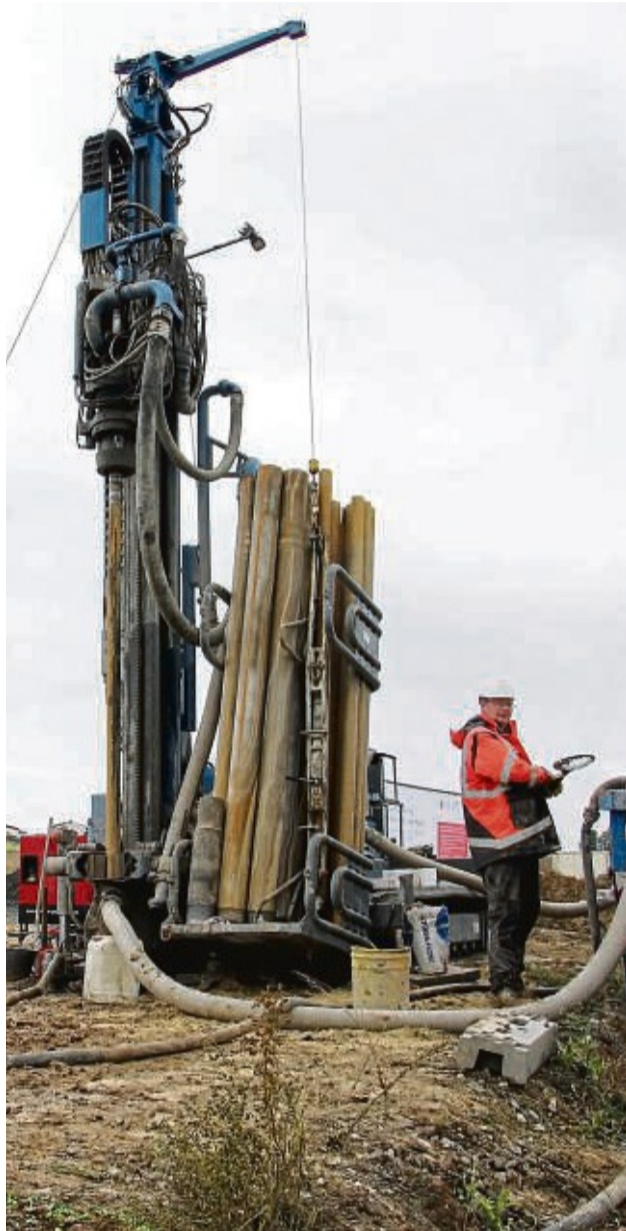
Das Bohrergerät gräbt sich bis zu 100 Meter tief: Für die Testbohrung werden insgesamt drei Tage benötigt. Mit den ermittelten Daten können die Geologie und die Wärmeleitfähigkeit des Erdreiches ermittelt werden.
