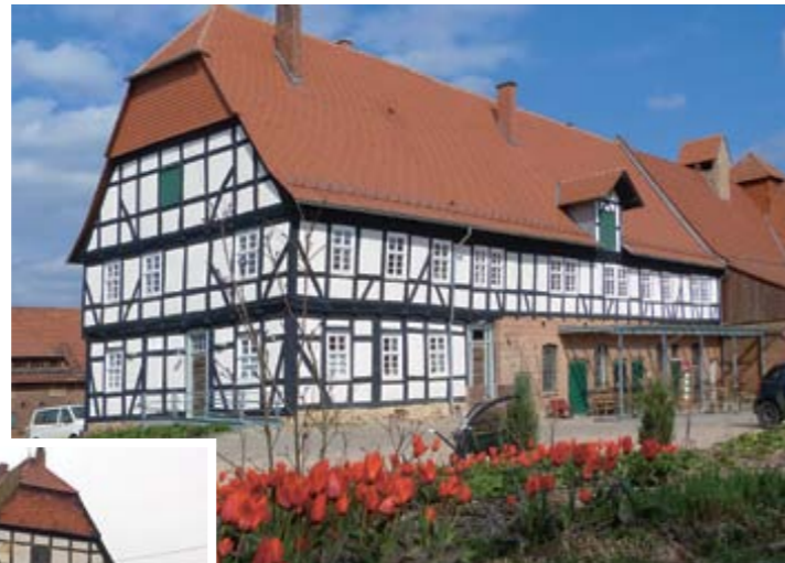
Amtshaus und Hof nach der Sanierung (Foto oben)
